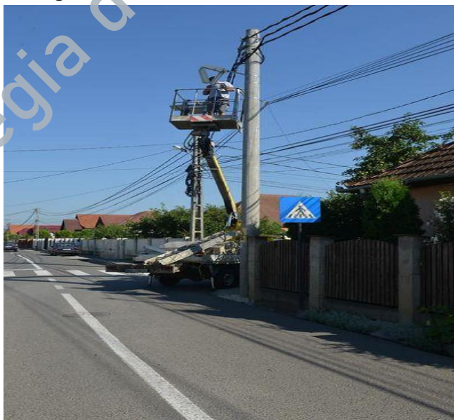
Fig. nr.20. Montarea becurilor LED, 2020
